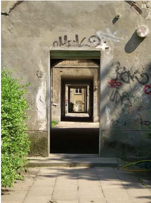
Hofabfolge Berlin Prenzl'-Berg, Kastanienallee 12
